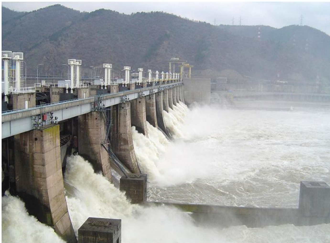
Управљање водама Дунава у профилу бране ХЕ Ђердап I у циљу оптималног коришћења хидроенергетског потенцијала и заштите од поплава; испуштање вишка великих вода преко прелива на брани 2006.
