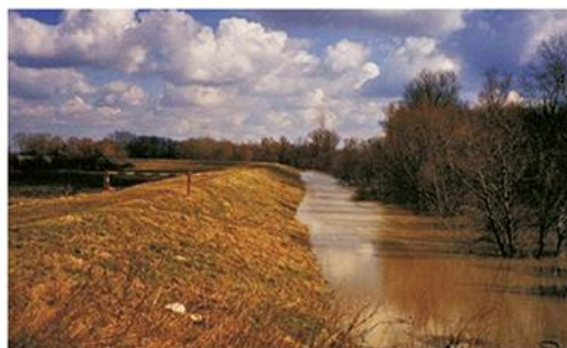
6. Насип на Тамишу код места Сечањ и попречни пресек типичног дунавског насипа: 1. екран од глиновитог, водонепропусног материјала; 2. баласт од песка из речног корита; 3. слој хумуса са травним покривачем. Висина насипа одређује степен заштите који зависи од вредности добара на брањеном подручју.
