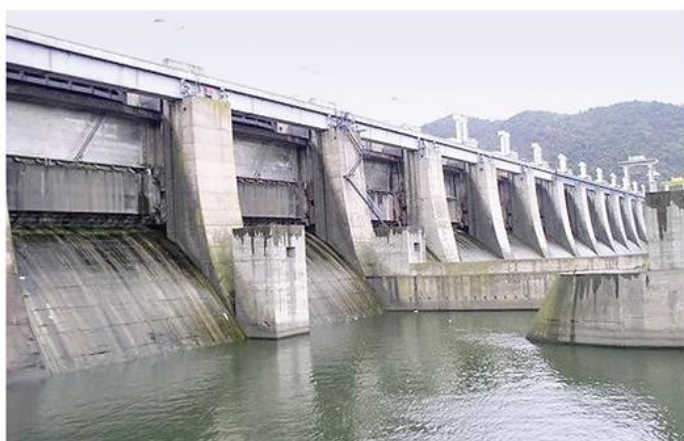
3. Преливни део бране Ђердап I са затвореним табластим уставама (лево) и током пропуштања велике воде (десно)
