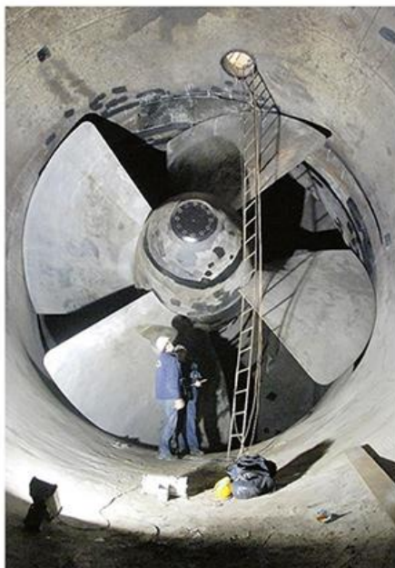
9. Лопатице хоризонталне Капланове турбине и командни пулт у ХЕ Ђердап II
