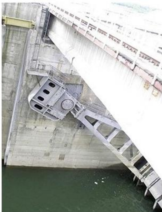
10. Сегментни затварачи на преливним пољима ХЕ Ђердап II
