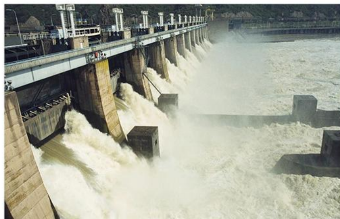
3. Преливни део бране Ђердап I са затвореним табластим уставама (лево) и током пропуштања велике воде (десно)
