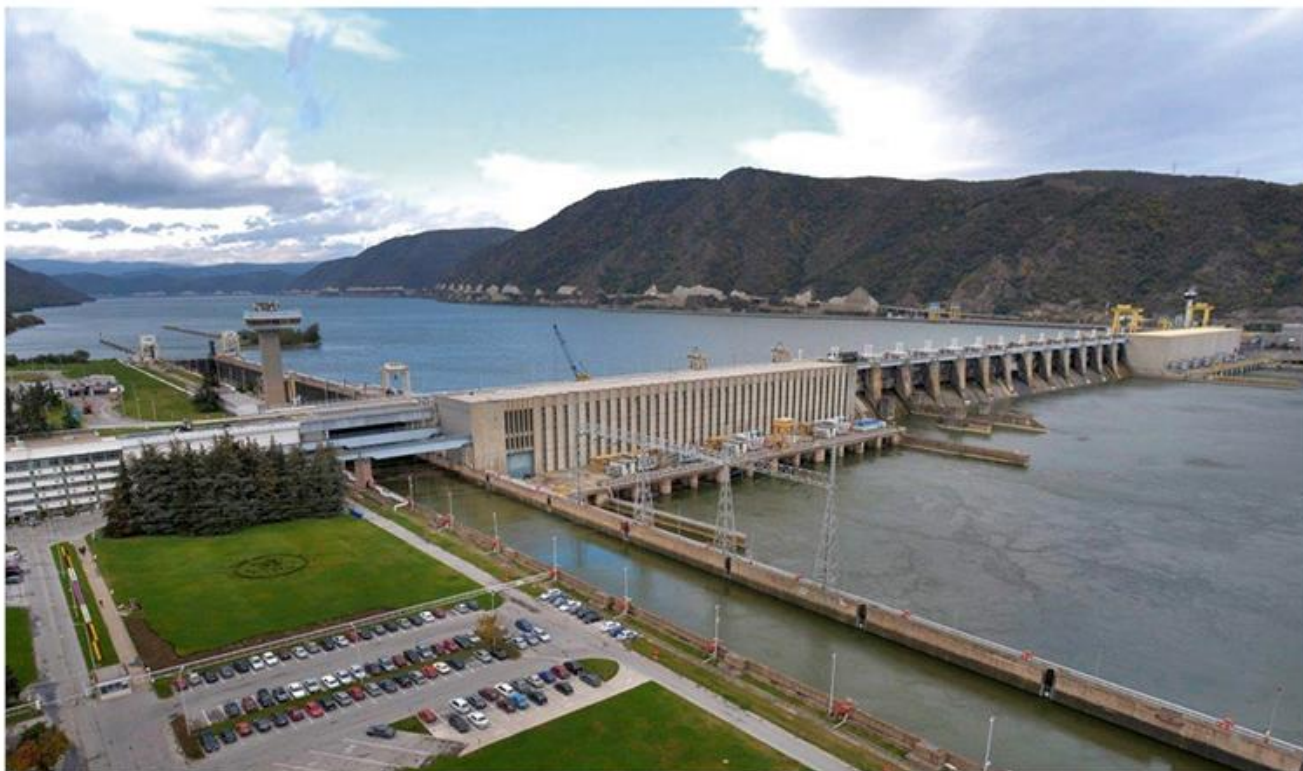
2. ХЕПС Ђердап I – објекти на српској страни, слева надесно: управна зграда, бродска преводница, електрана, преливни део бране
