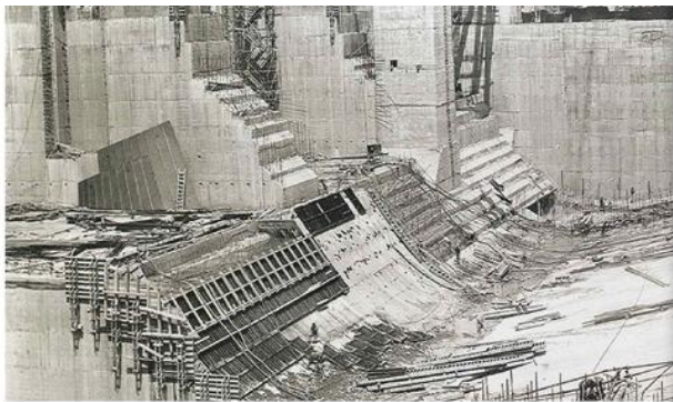
7. Бетонирање преливног дела бране под заштитом загата II фазе
